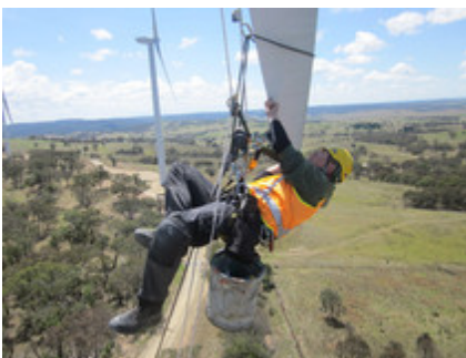
Schwindelfreie Servicetechniker müssen regelmäßig die Rotorblätter inspizieren und kleine Schäden reparieren. © Seilpartner Windkraft GmbH
